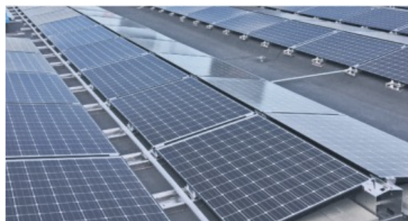
SYSTÈME DE MONTAGE EST – OUEST ANGLE D'INCLINAISON 10°
