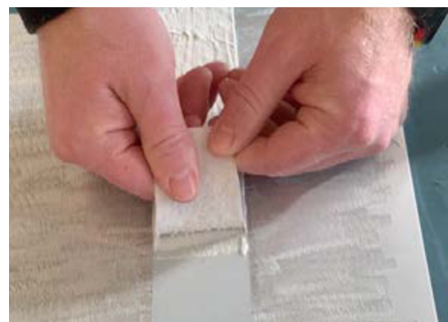
Von Hand abziehen. Die Armierung löst sich von der unteren Schicht des Flüssigpolymers.
