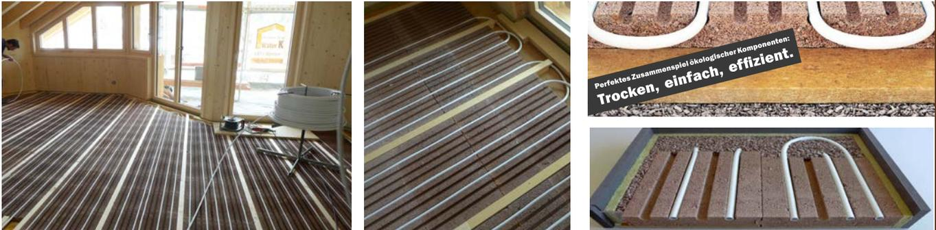
Das Lithotherm-Rohr ist das ins System passende, geprüfte Alu- Kunststoffverbundrohr mit Systemgarantie. Es hält einer maximalen Betriebstemperatur von 95° (kurzzeitig 110°) und einem maximalen Betriebsdruck von 12 bar stand.
