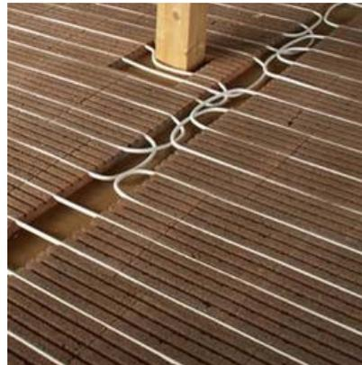
Ausnehmungen an den Rändern und an den Türdurchgängen mit schnelltrocknendem Sackestrich oder gebundener Trockenschüttung CW 2000 auffüllen.
