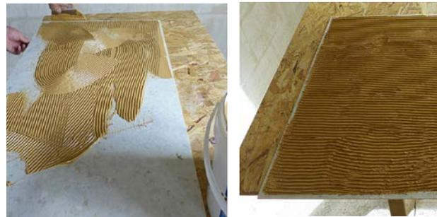
muss der Klebemörtel mind. 5 Stunden trocknen, bevor mit der Verlegung der Keramikplatten oder des Klebeparkettes begonnen werden kann.
