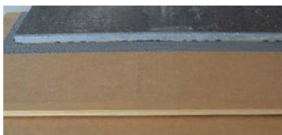
Randdämmstreifen: Wenn auf einer Baustelle die Randdämmstreifen fehlen resp. abgeschnitten wurden, muss eine Montage eines Randdämm
