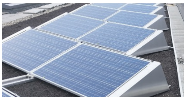
MONTAGESYSTEM SR, NEIGUNGSWINKEL 10° / 20°. SÜDLICHE AUSRICHTUNG
