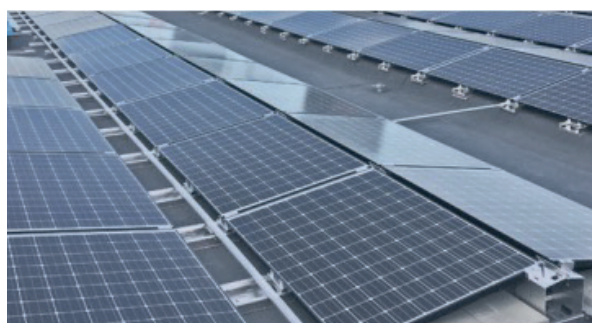
SYSTÈME DE MONTAGE EST – OUEST ANGLE D'INCLINAISON 10°
